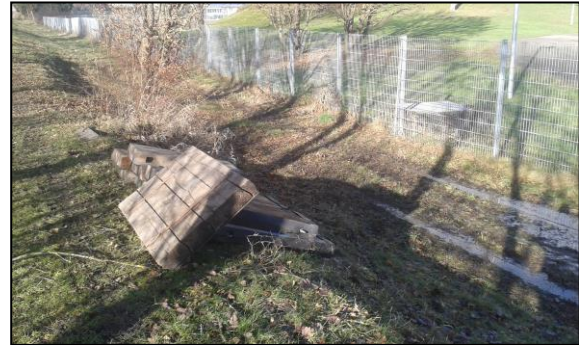
Bild: altes Einlaufbauwerk mit Dammbalken
